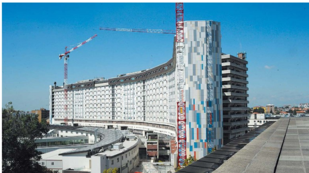
Il cantiere dell'ospedale San Gerardo di Monza (Fotogramma)
