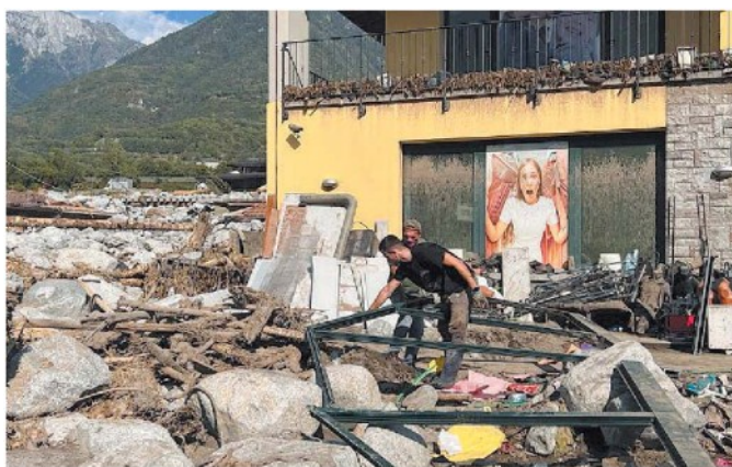
Si tolgono le macerie per provare a valutare i danni
