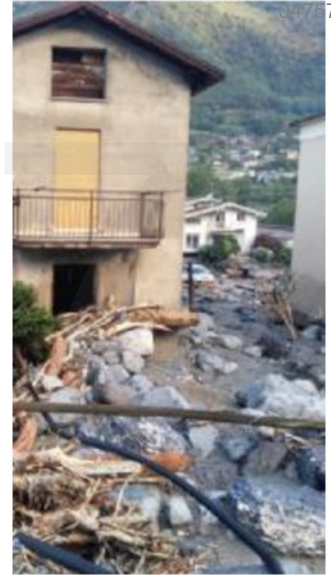
I detriti nelle strade di Niardo
