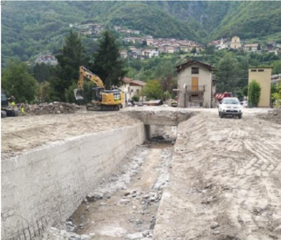
Mezzi al lavoro per ripristinare quella parte di territorio gravemente danneggiato dal maltempo
